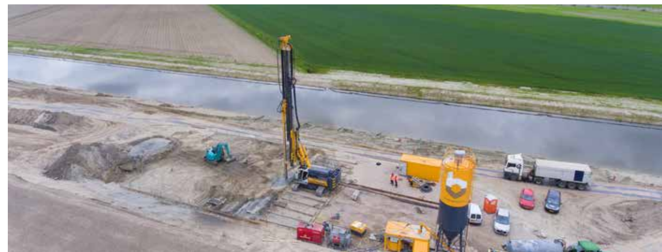
De productie van de CSM-panels op locatie Oostpolderdijk Eemshaven door BodemBouw.
