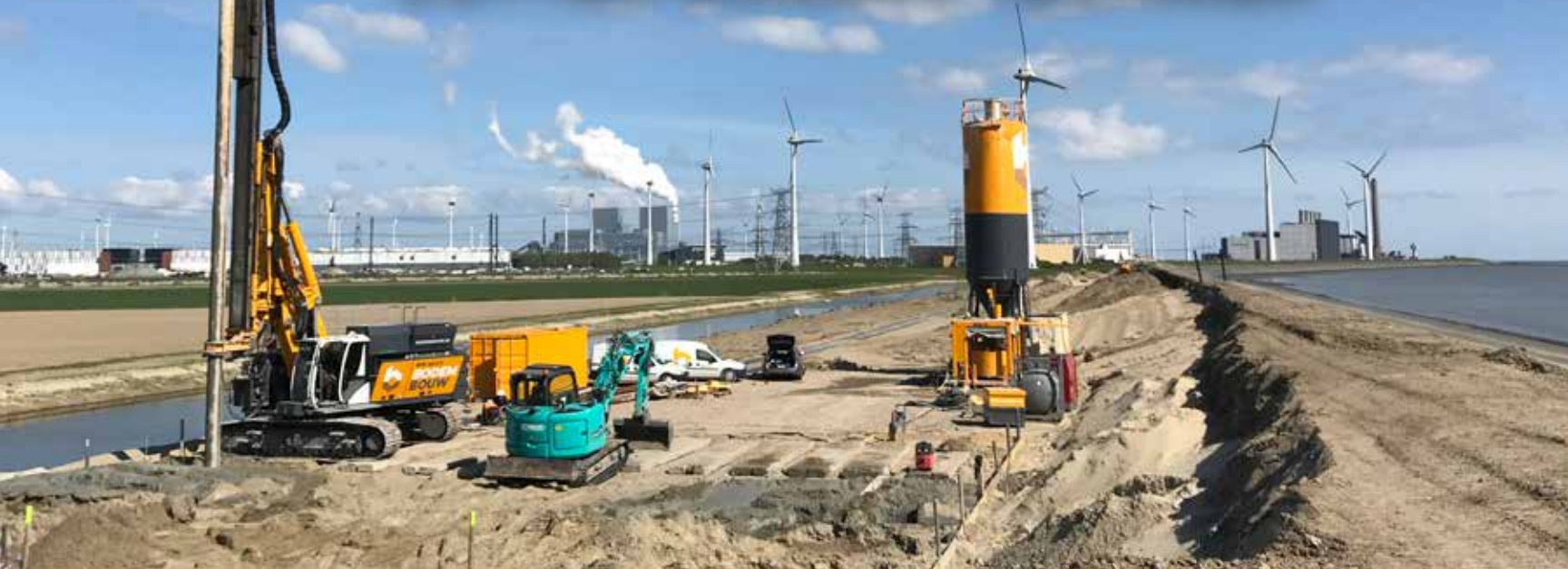
CSM-panels als fundaties grondverbetering voor windturbines Oostpolderdijk Eemshaven. BodemBouw in samenwerking met innogy en combinatie Ommelanderdijk.
